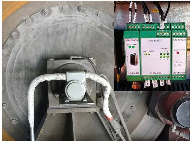
Nachher: Direktanbau des U-ONE-Basisgeräts mit Elektronikmodulen im Schaltschrank
